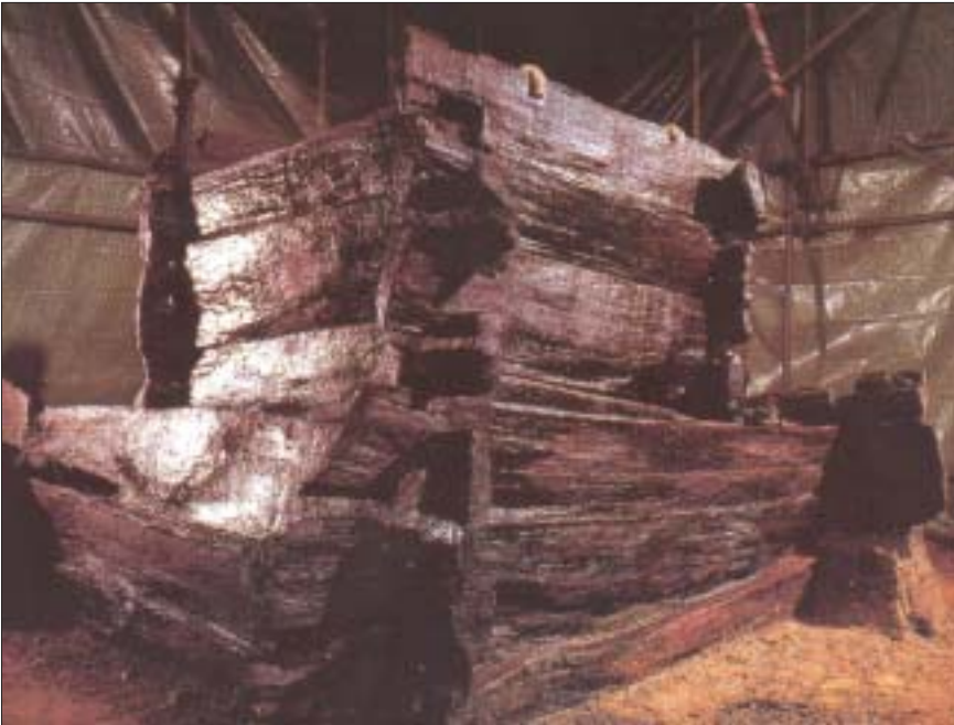
Jungsteinzeitlicher Brunnenfund, der 1990 in einer Kiesgrube in der Nähe von Erkelenz entdeckt wurde und aus dem Jahre 5090 v. Chr. datiert. Es handelt sich um das älteste, bis heute entdeckte Holzbauwerk der Erde.
